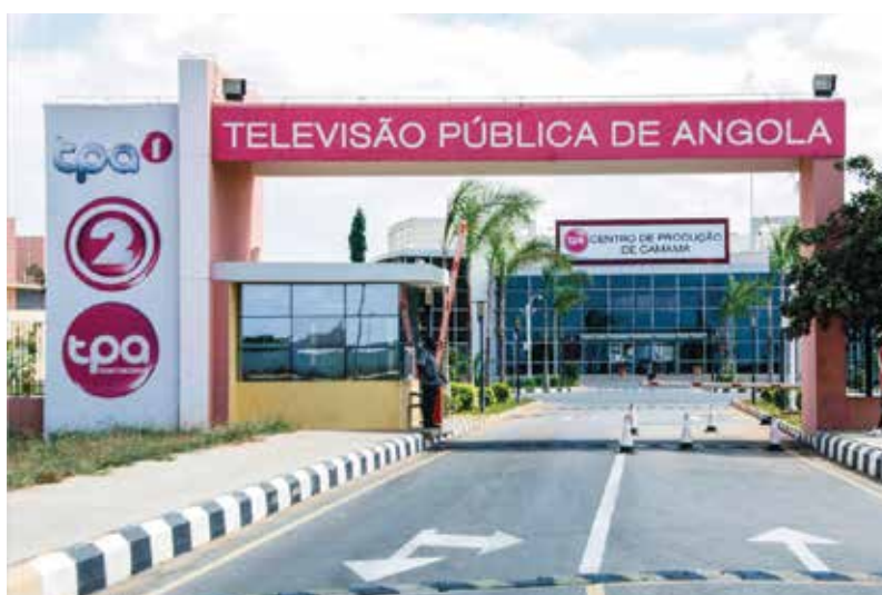
Fig. 26 - Instalações da T.P.A. - Camama.
