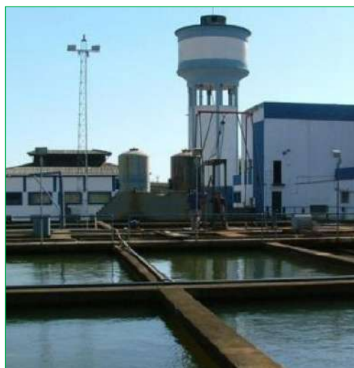
Fig. 44. Estação de Tratamento de Águas - ETA.
