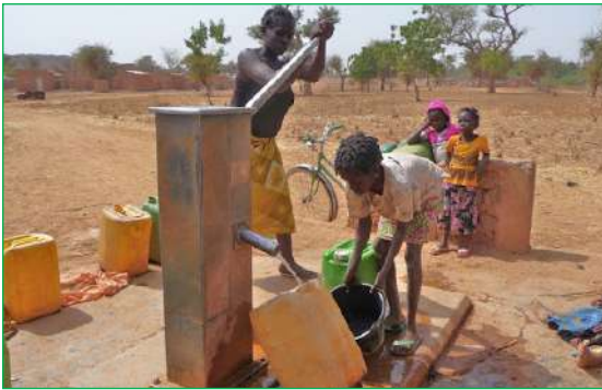
Fig. 26. Aproveitamento de águas subterrâneas.
