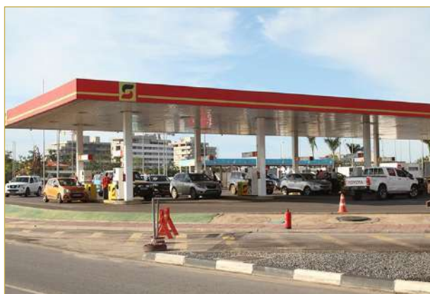
Fig. 36. Posto de abastecimento de combustível.
