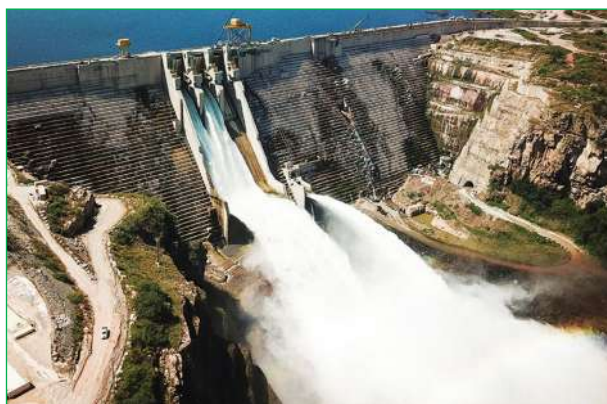
Fig. 24. Barragem de Laúca.
