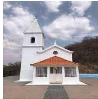
Fig. 7 - Capelinha da Nossa Senhora do Monte.
