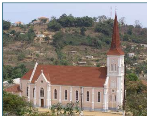
Fig. 7. A Igreja de Lândana, em Cabinda.
