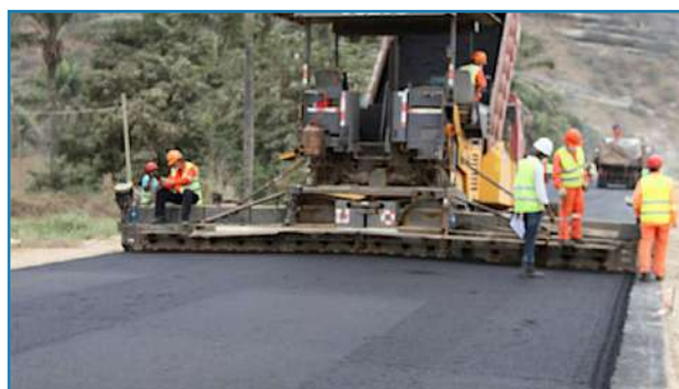
Fig. 44. Construção da estrada do Nóqui.
