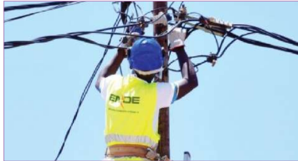
Fig. 23. Reparação de uma linha de distribuição de electricidade.
