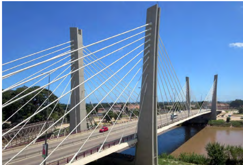
Figura 12 Estrutura artificial: ponte sobre o rio Catumbela.
