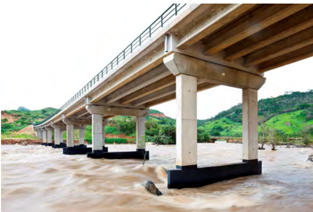
Figura 14 Exemplo de estrutura resistente à carga: ponte sobre o rio Keve.
