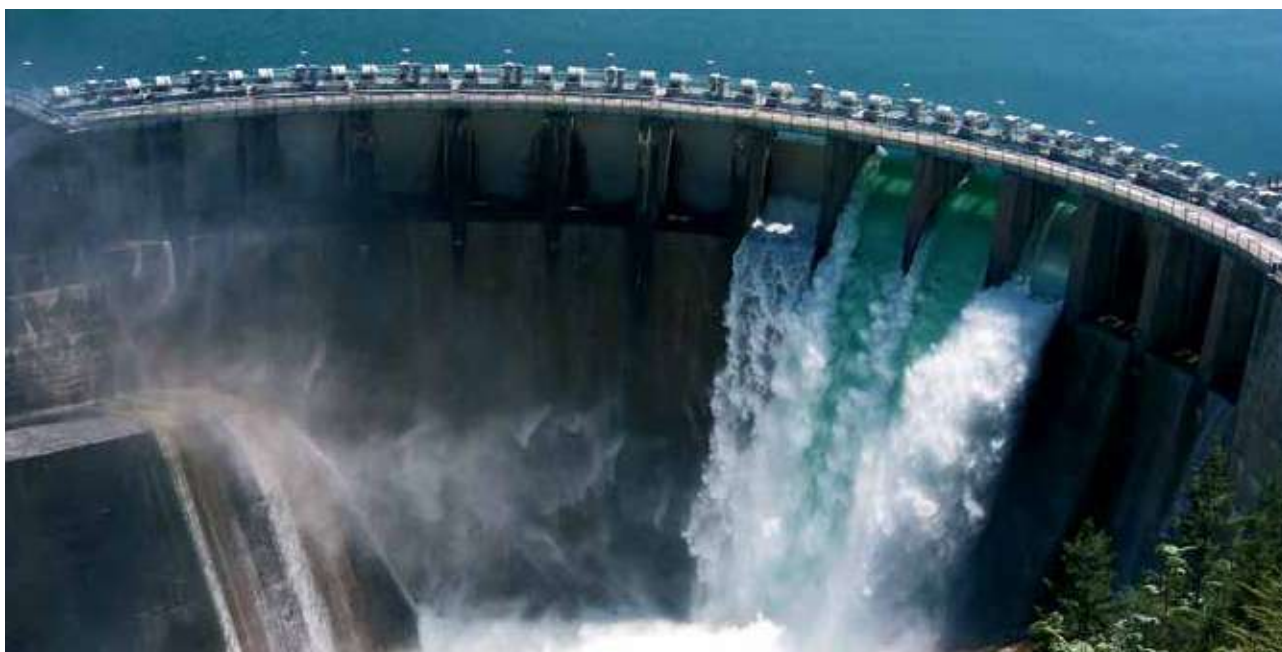
Fig. 21 - Vista de uma grande barragem.
