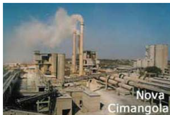
Fig. 11 - Fábrica de cimento Nova Cimangola.
