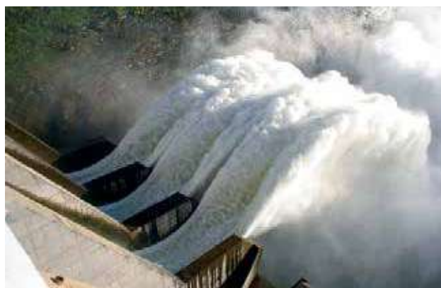
Fig. 23 - Barragem com três represas.
