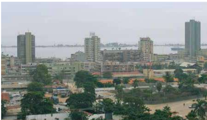
Fig. 24 - A cidade de Luanda é iluminada pela energia das barragens.
