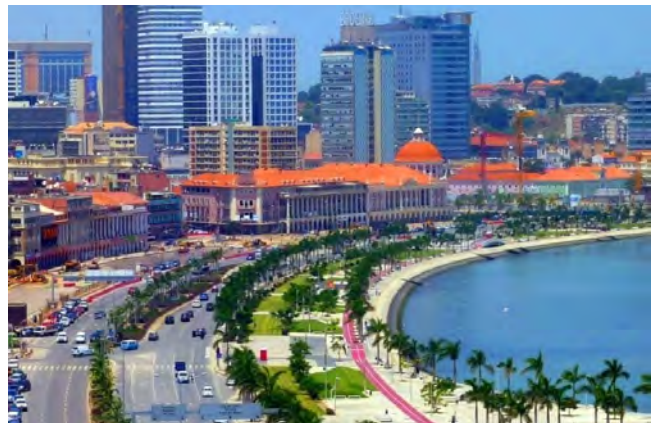
Fig. 29 - Na marginal de Luanda há casas feitas de tijolos e de blocos (cimento).
