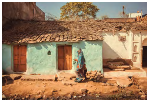
Fig. 9 - Casa de blocos e cimento.
