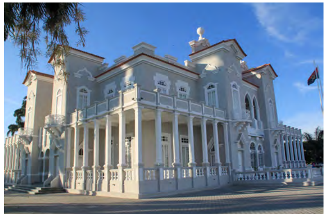
Fig. 27 - Um edifício feito de vários materiais.
