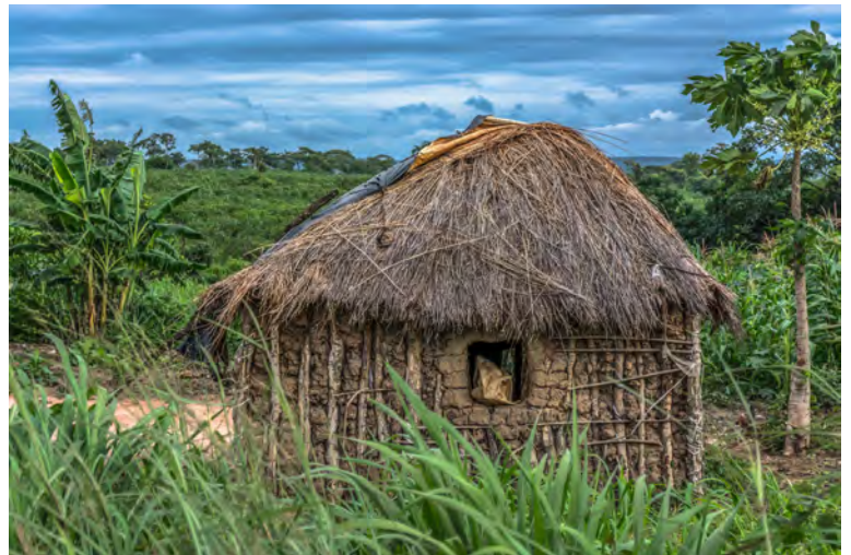
Fig. 31 - Uma casa de pau-a-pique construída numa zona não alagadiça.
