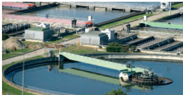
Fig. 76 - Estação de tratamento de água.
