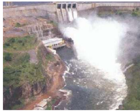
Fig. 32 - A barragem de Cambambe.
